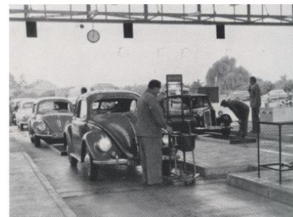
Teste de luzes em um carro com dispositivo de testes Bosch
